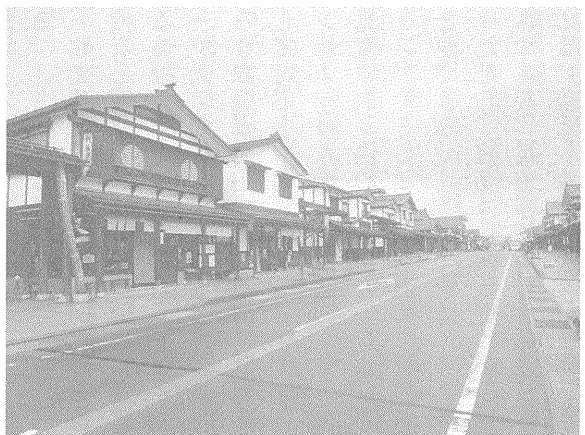
電線類は地中化し、歩道は石畳み舗装など伝統的な工法を用いた牧之通り 景観
